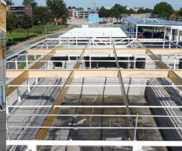
Het betonwerk voor de zwembaden werd gelijktijdig met de ingebruikname van de sporthal afgerond.
