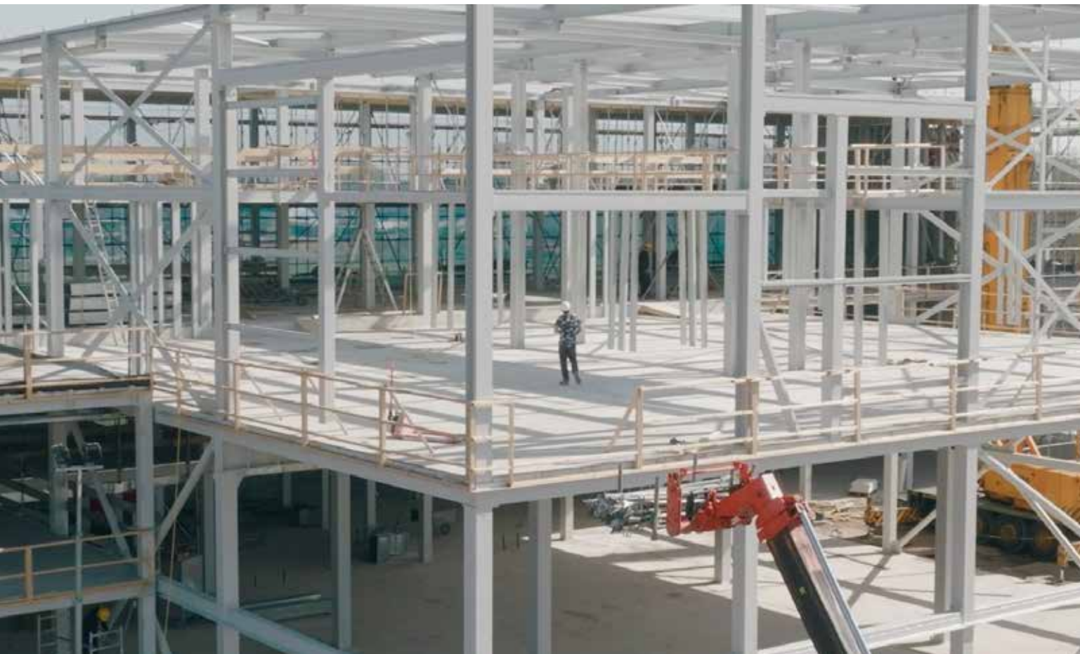
Tasche produceerde en monteerte de staalconstructie van de nieuwe school.
