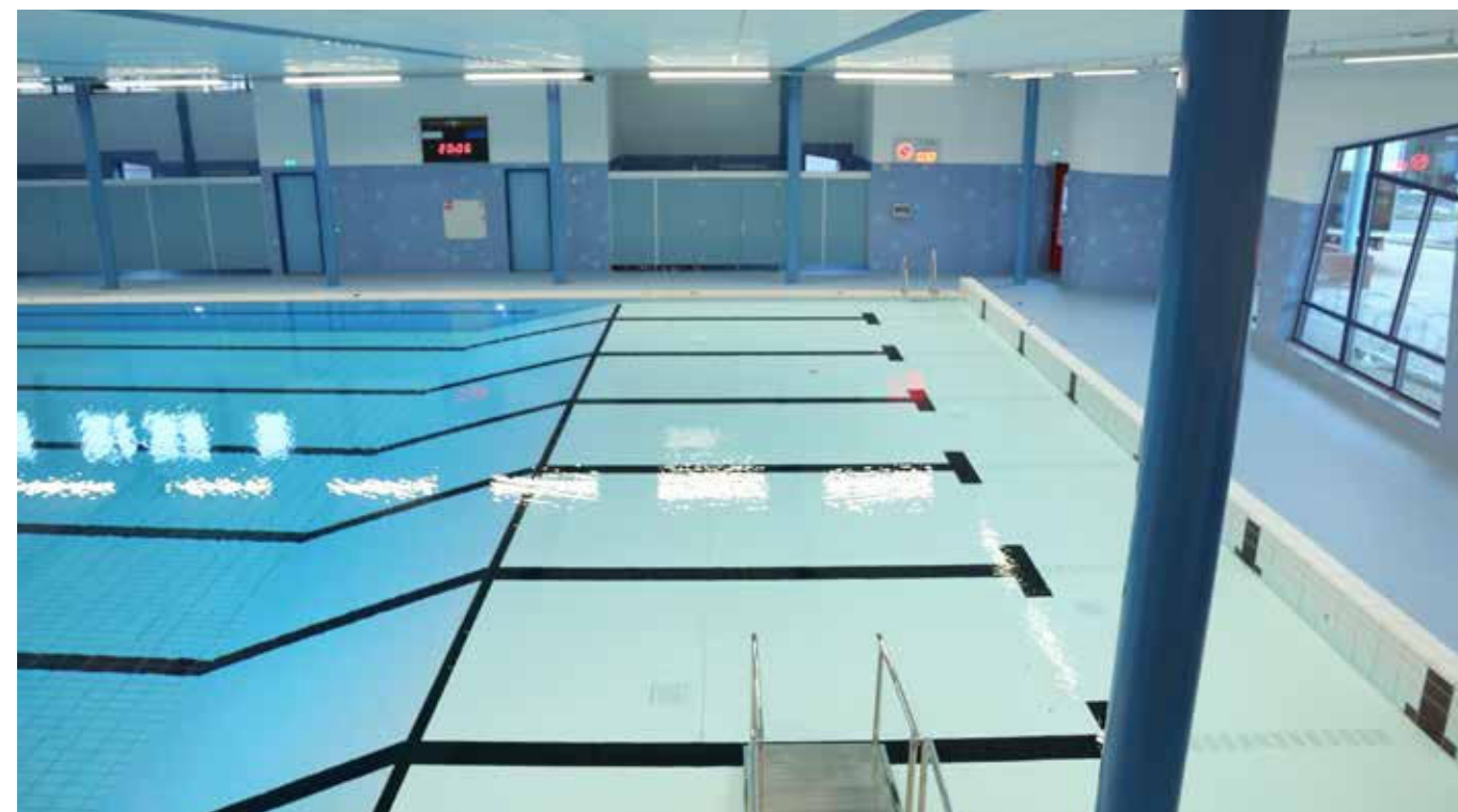
Het Sporthuis bestaat uit een zwembad met een 25 meter wedstrijdbad met beweegbare bodem, kleedruimtes en een koffiehok.
