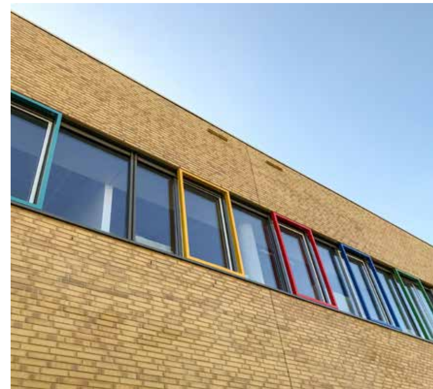
Op voorschrijven van de architect is gekozen voor een renovatiesteen van 7 cm breed.
