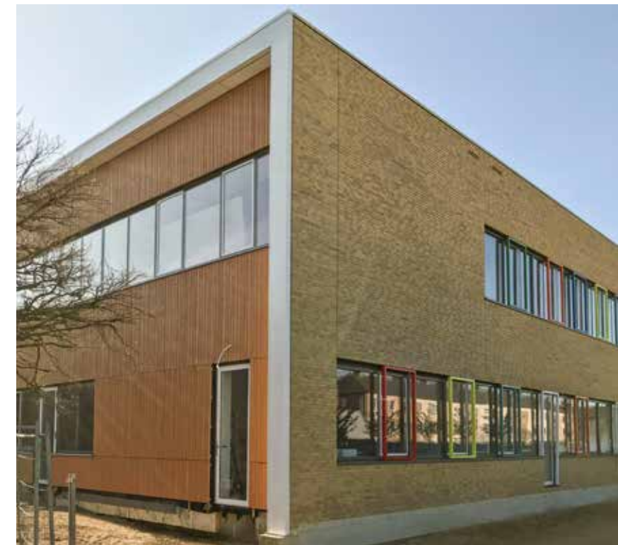
In de voor- en achtergevel is een groot rechthoekig kader van wit gepoedercoat staal gerealiseerd, die perfect aansluit op het gevelmetselwerk van de langgevels.
